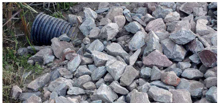
Photo prise par Groupe ProConseil. Exemple d'ouvrage hydroagricole, dans ce cas-ci une chute enrochée réalisée à la ferme Normen.
