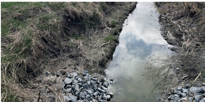
Photo de la berge érodée à travailler, Saint-Jean-Baptiste.
