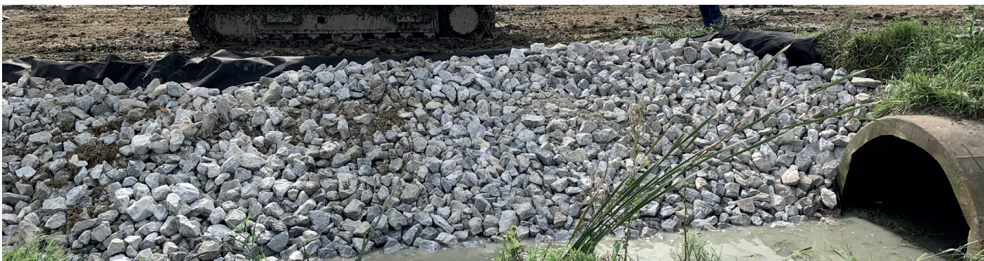
Travaux de stabilisation réalisés à Saint-Jean-Baptiste
