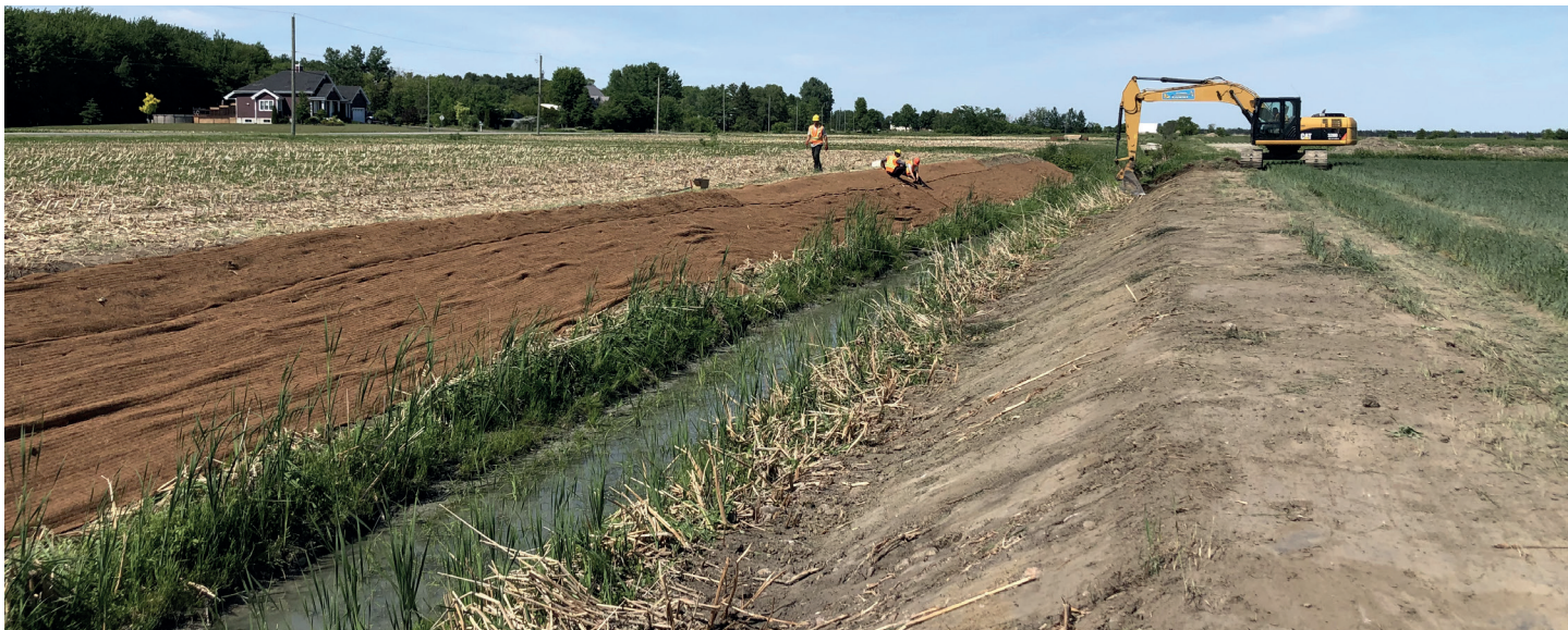
Terrasse d'environ 1 m de largeur. Travaux de stabilisation réalisés à Saint-Jean-Baptiste.
