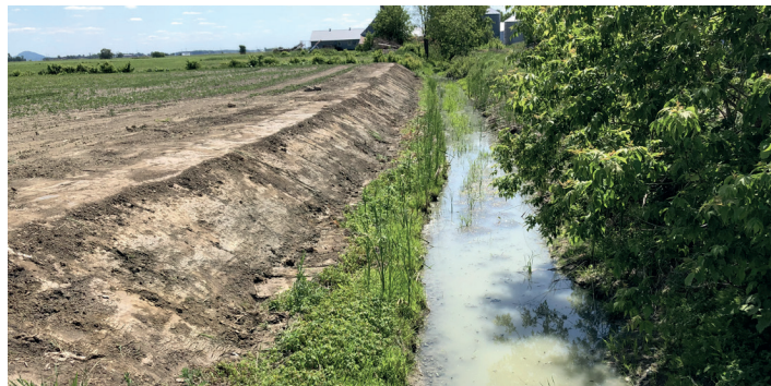
Adoucissement de la pente et chute d'enrochement
