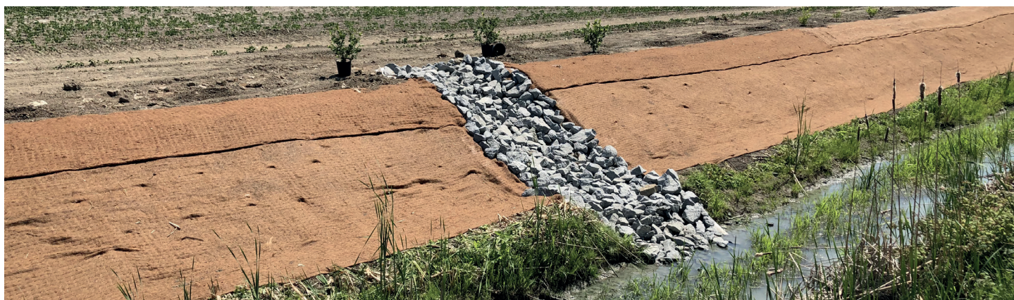
Fixation des toiles antiérosives avec des piquets de cèdre. Travaux de stabilisation réalisés à Saint-Jean-Baptiste.
