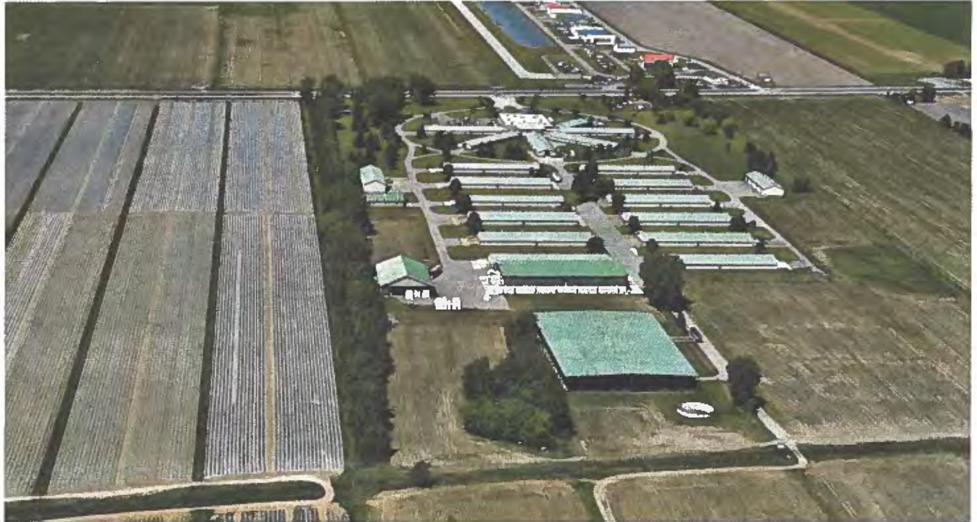
Selon son propriétaire, l'aéroport de Saint-Hyacinthe ne représenterait pas un obstacle insurmontable dans le cas d'une vente du terrain de Semex à une entreprise qui souhaiterait construire un bâtiment plus élevé. Photo www.fermes.quebec
