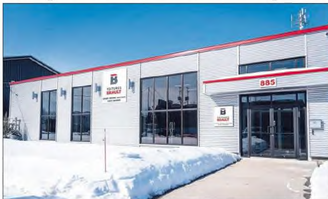
En plus du Québec, Toitures Brault est établi au Nouveau-Brunswick, à l'Île-du-Prince-Édouard, en Nouvelle-Écosse, en Ontario, en Alberta et en Colombie-Britannique.
