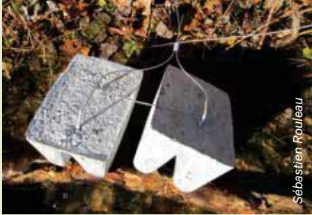
Figure 5.31 Blocs de béton utilisés comme ancrage de troncs d'arbres flottants
