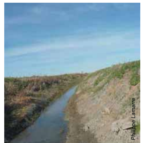
Figure 5.12 Fossé à nu
