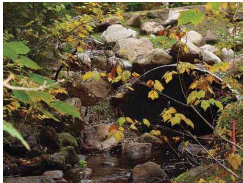
Figure 5.17 Ponceau en arche
