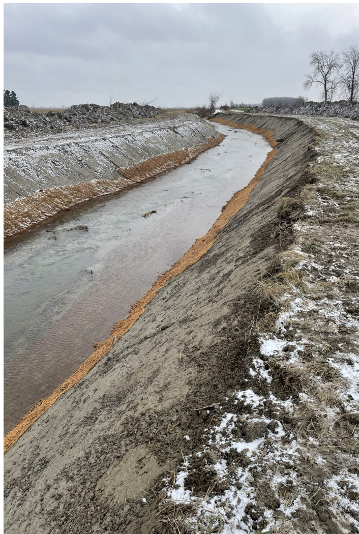
Chenal à deux niveaux avec les matelas anti-érosion
