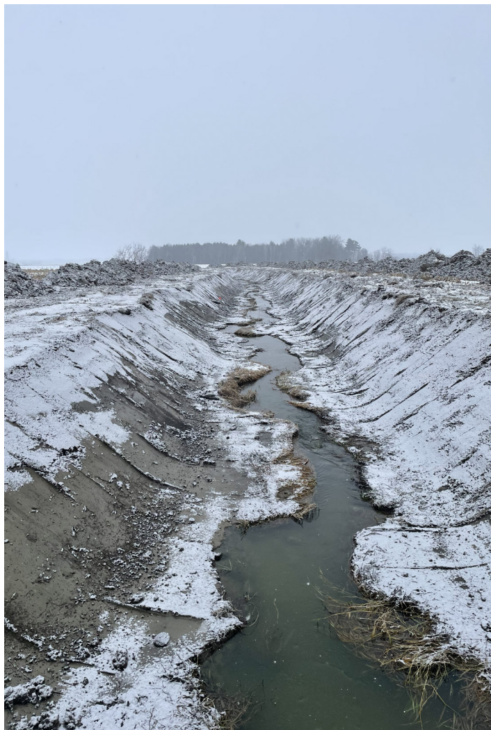
Branche 17 de la 3 e rivière Pot au Beurre pour donner suite aux travaux d'excavation
