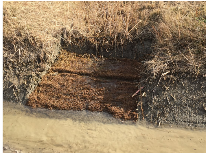
Rivière Pot au Beurre, la principale. Stabilisation de fossé
