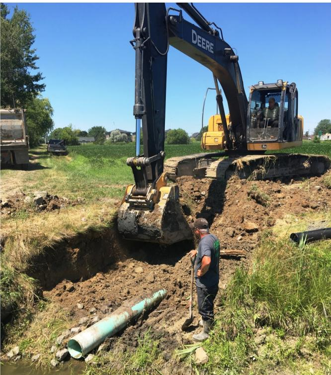
Réalisation de chute enrochée et sortie de drain
