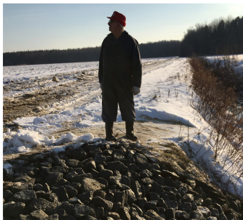
Déversoir enroché (Ferme Claude Dufault)
