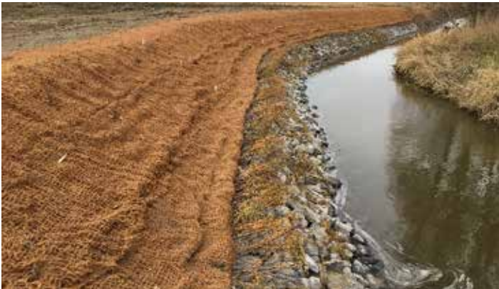
Stabilisation de berges par génie végétal avec clé d'enrochement et plantation sur le replat de la bande riveraine élargie.
