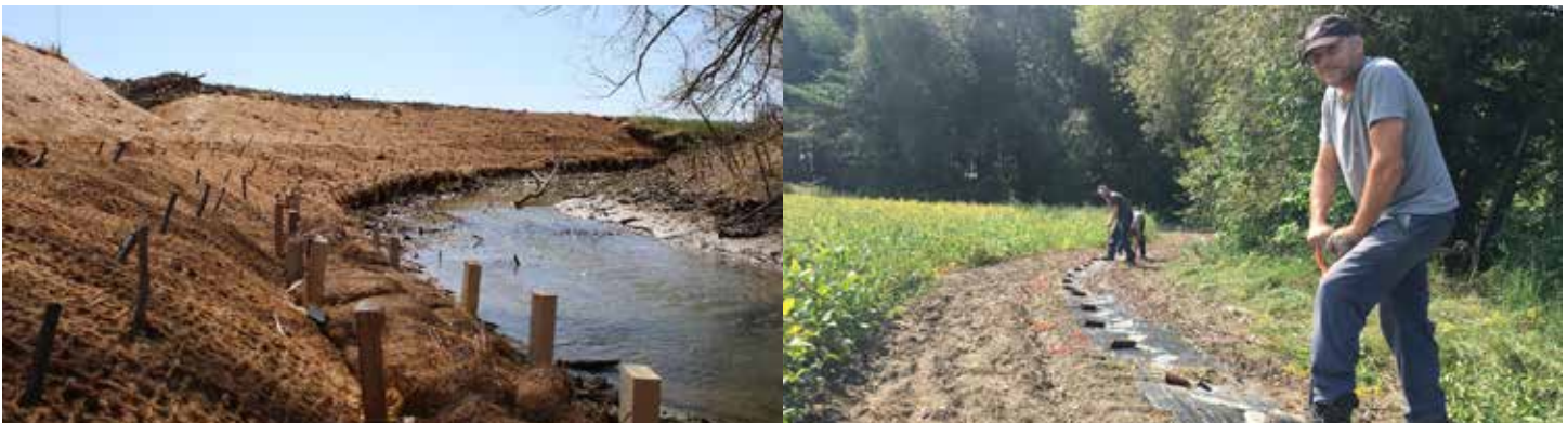
Stabilisation de berges par génie végétal avec boudins et plantation sur le replat de la bande riveraine élargie (Ferme G. Forcier et fils, Saint-Robert).
