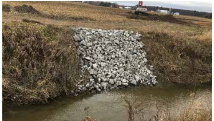
Déversoir enroché (Ferme du Rang Saint-Pierre, Ste-Victoire-de-Sorel).
